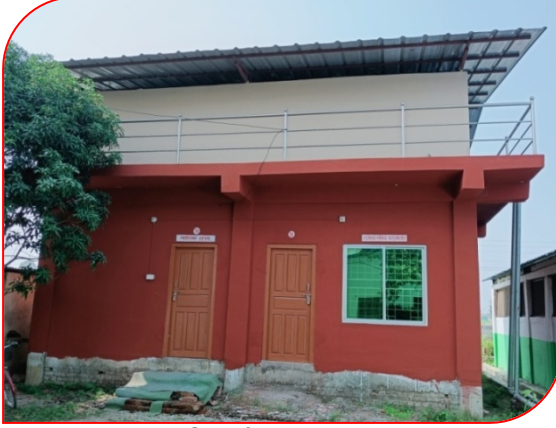
ट्रस सहितको क्वाटर मर्मत
