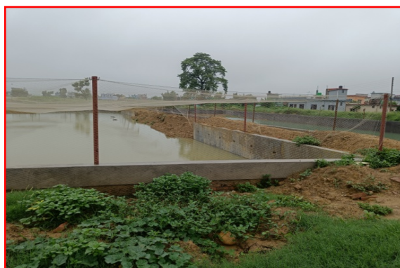
नेटिङ्ग सहितको पक्की डिल निर्माण
